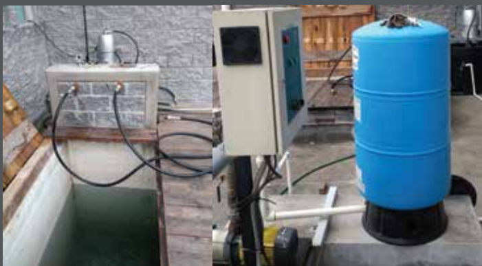
INSTALACIÓN HIDRÁULICA PARA PRUEBA DE PRESIÓN
